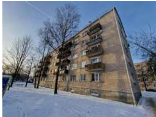
Dzīvojamā māja Metālistu ielā 5
