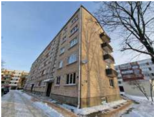
Dzīvojamā māja Metālistu ielā 5
